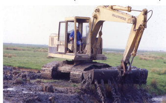
Curage d'un fossé dans le marais de Brouage
